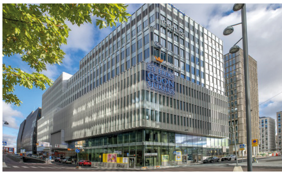
ST. ERIK - EYE HOSPITAL STOCCOLMA - (SVEZIA)
